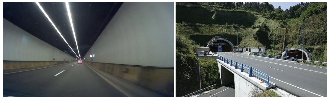
Figura 15: Distintas superficies de contraste túnel Malmasin y alumbrado de Guiado en báculos en túneles de Artxanda.
